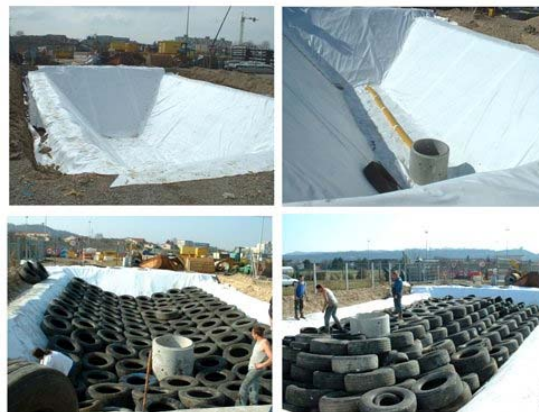
Figure 3 : Valorisation de PUNR en bassin de rétention
